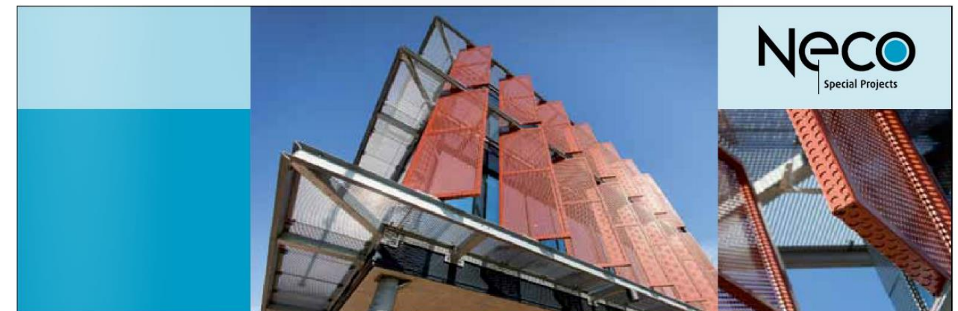
In de zuidgevel, waar de zon 's zomers hoog staat, houden bordessen directe zonnestraling tegen.
